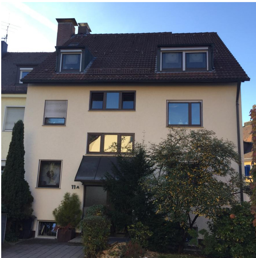
WEG Verwaltung / 3 Einheiten / Nürnberg Zabo
